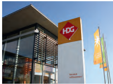
Fertigstellung des Verwaltungsgebäudes
